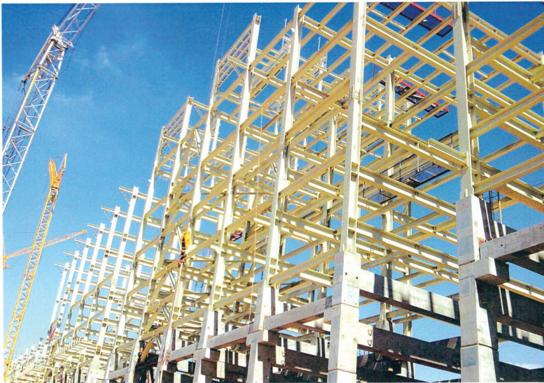
Элементы каркаса эстакады (нефтеперерабатывающий комплекс, г. Нижнекамск)
