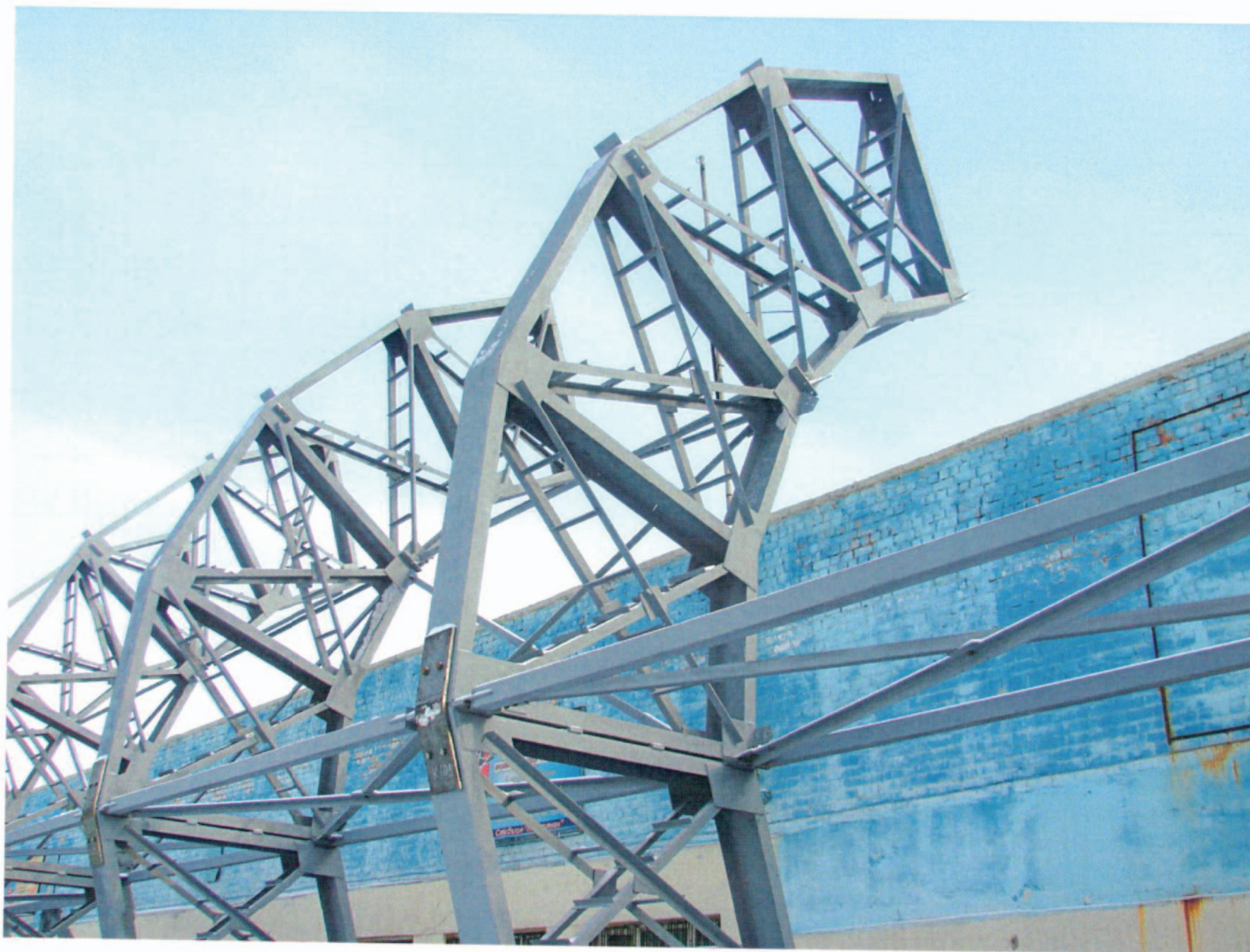
Элементы конструкции навеса стадиона
