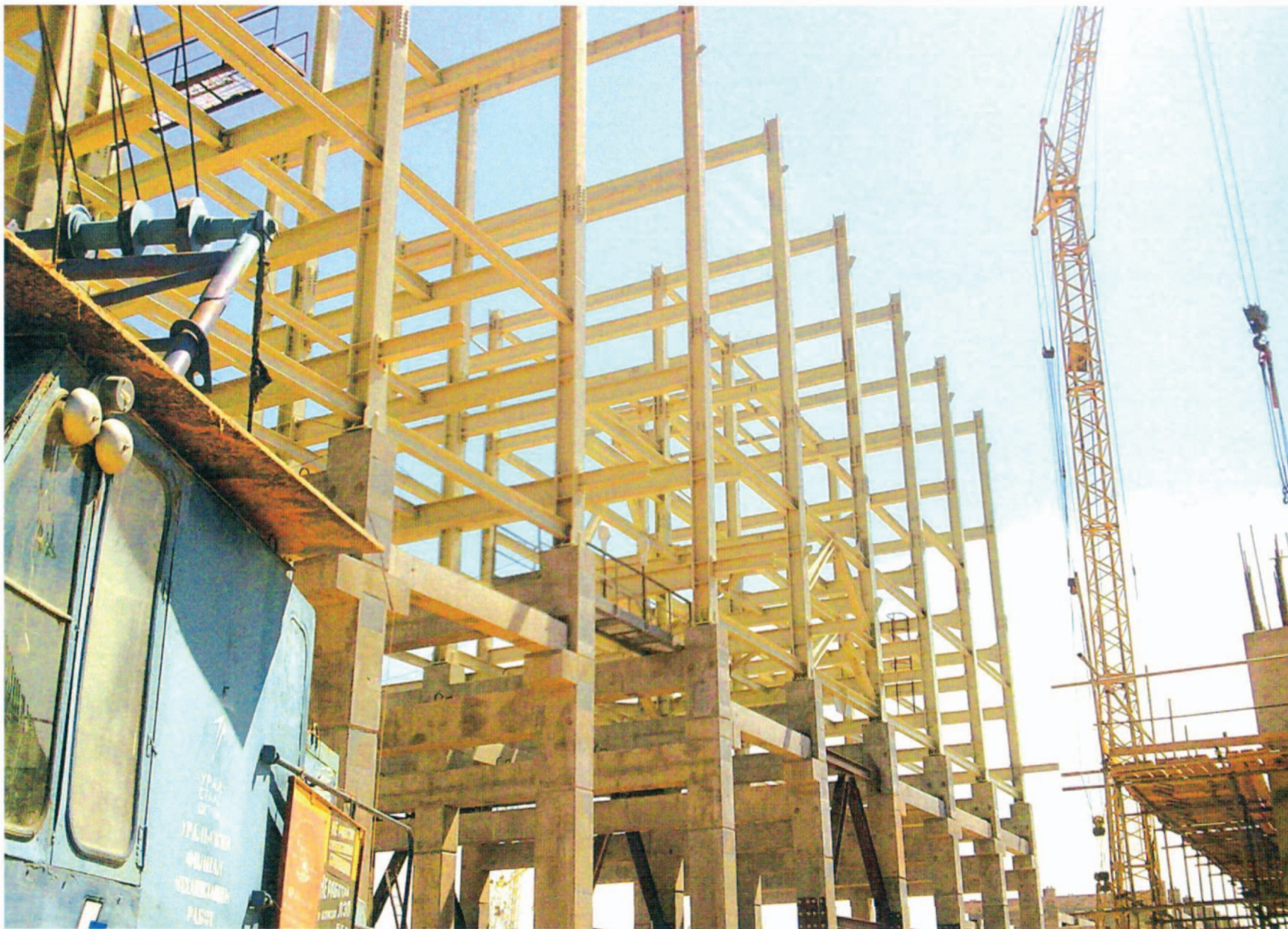
Элементы каркаса эстакады (нефтеперерабатывающий комплекс, г. Нижнекамск)
